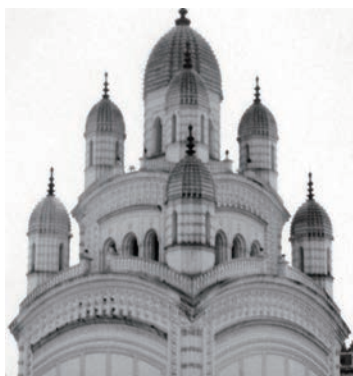
カーリー堂のバルコニー
